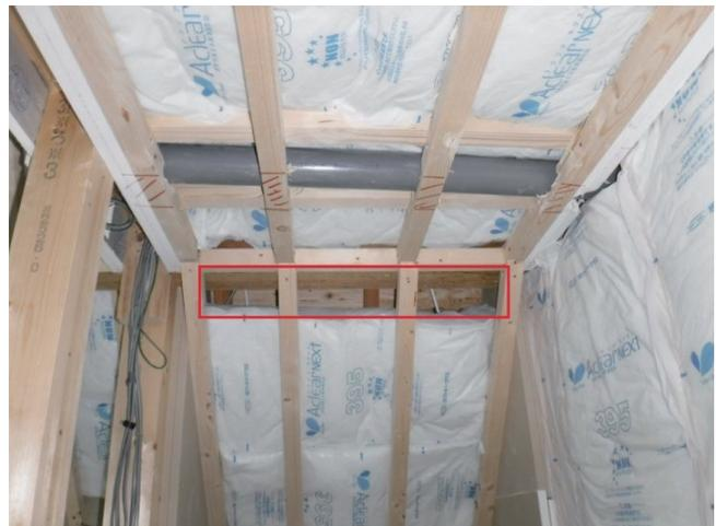
新築現場で断熱材に隙間が生じていた事例
