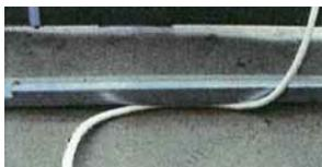
写真 5 モジュール固定金具下へのケーブルの挟み込み箇所
