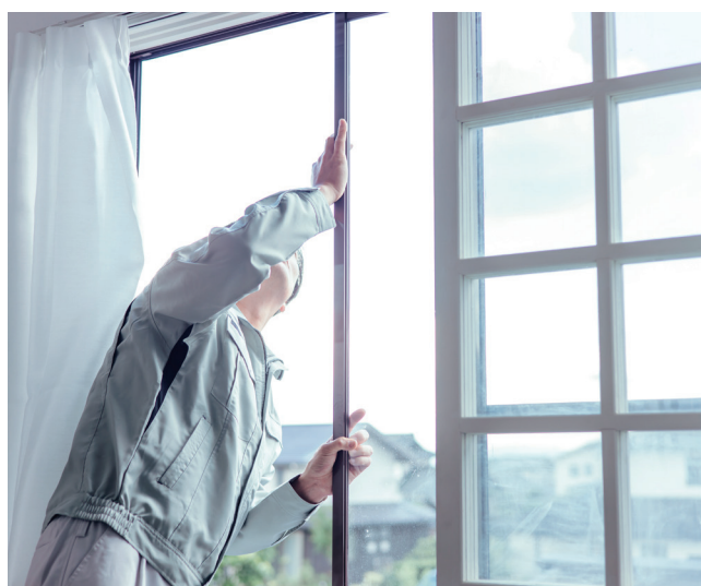
窓の施工の様子※画像はイメージです
